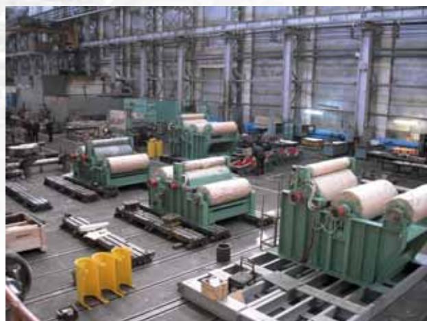
Этап изготовления узлов линии цинкования металла. Установлены на ОАО «Лысьвенский металлургический завод»
